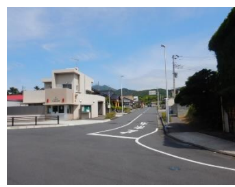
島しょ地域の無電柱化(大島)
