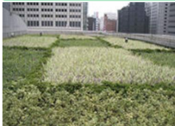
屋上緑化（都議会議事堂屋上）
