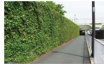
壁面緑化〈小平市内・新小金井街道〉
