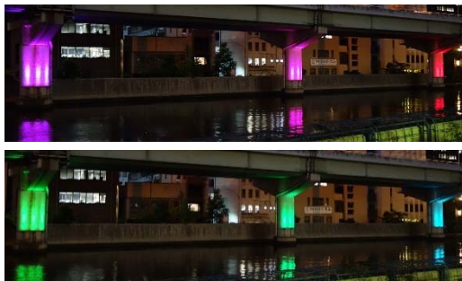
阪神高速橋脚ライトアップの色彩変化 (色相グラデーション) (大阪市堂島川)
