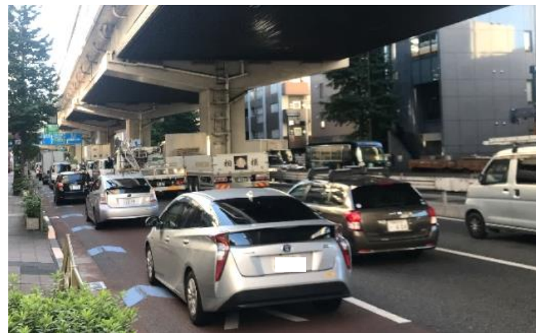
2019年7月試行時の環状七号線外側 (国道246号上馬交差点付近)
