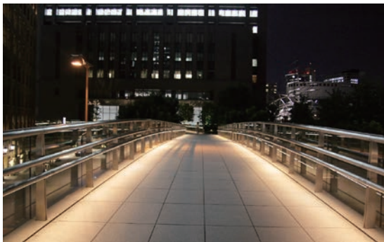
図 25 高欄照明の例
