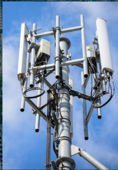
共有アンテナ設置
