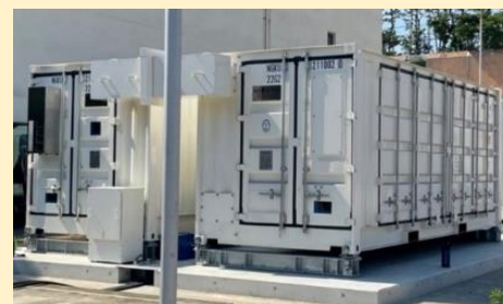
大型蓄電池再構築
