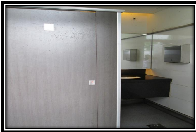
MISSING DOOR KNOB
