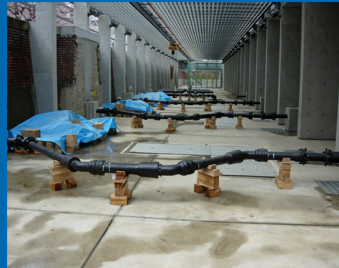
【実技フィールド(小口径配管実技場)】
