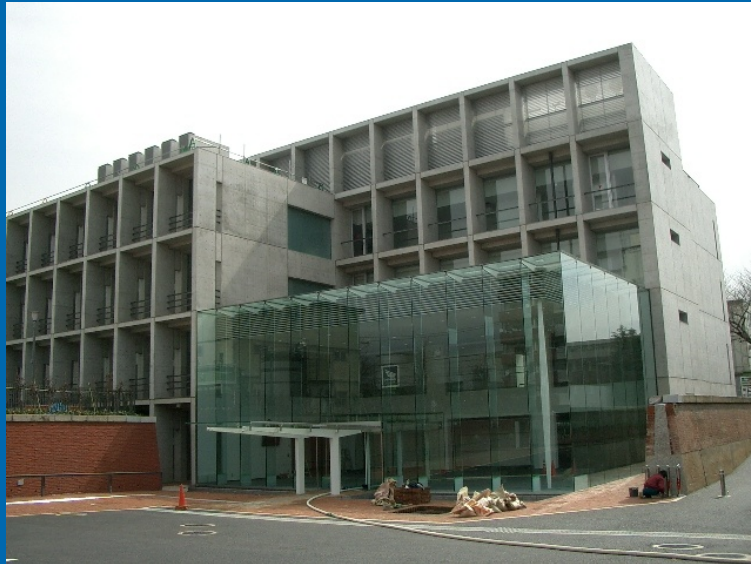
【研修・開発センター庁舎外観】
