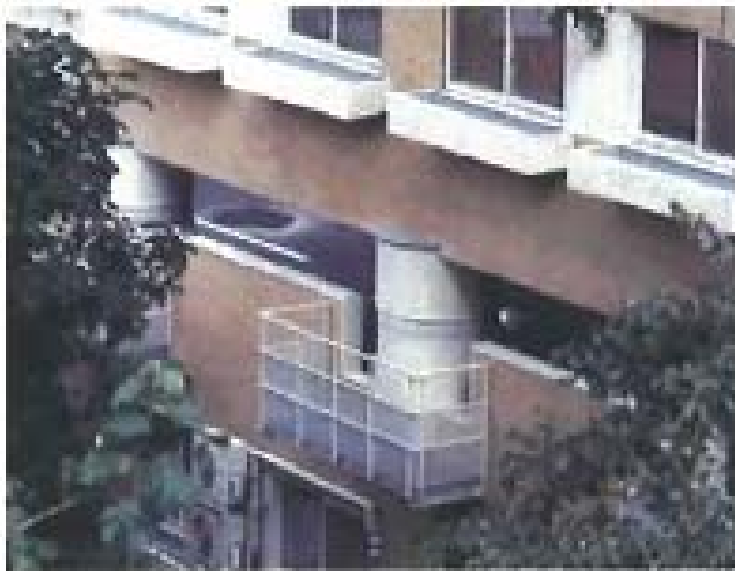
免震階の状況(耐火被覆あり)
