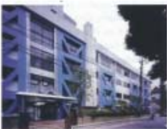
耐震性向上のための ブレースを追加した例
