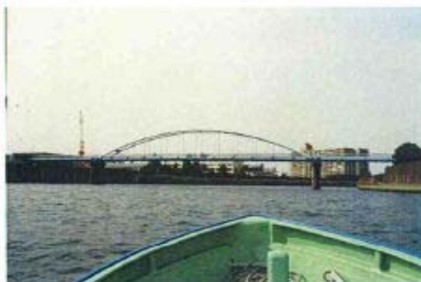
隅田川緑町水管橋 荒川-3
