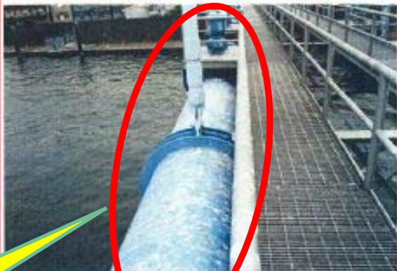
隅田川緑町水管橋 荒川-3
