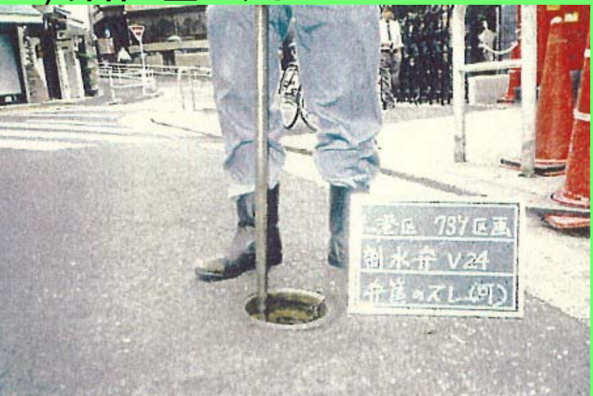
13) 弁棒と蓋のずれ
