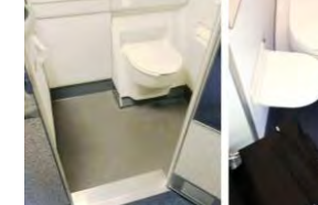
車いす対応トイレ
